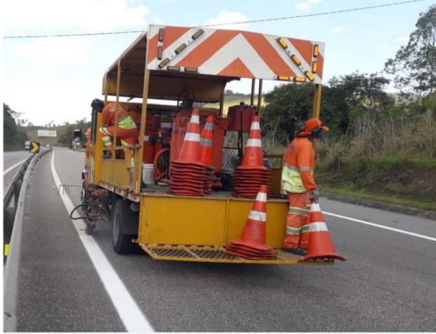
Figura 101 - Pintura de faixas - KM 20+500 Norte – F2
