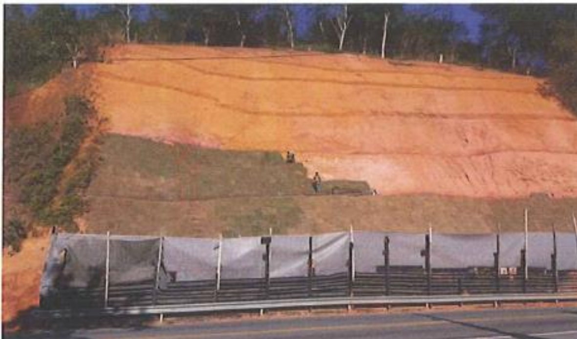
Figuras 94, 95 e 96 - Obra de recuperação e cobertura vegetal no talude localizado no km 35,2, sentido norte.
