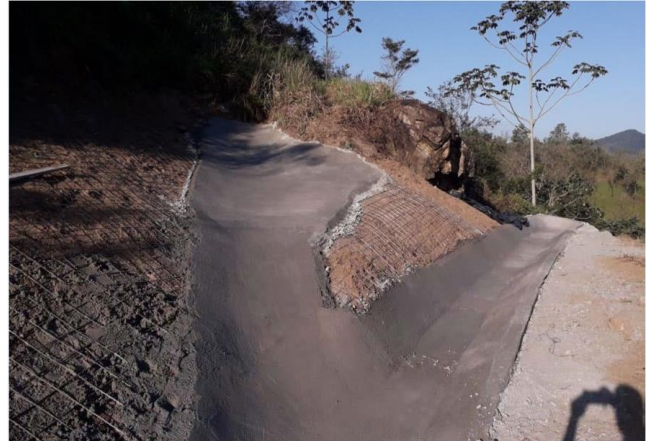
Figura 116 - Drenagem Talude Km 15,7
