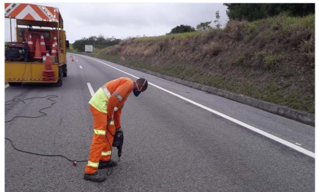
Figura 106 - Implantação de Tachas - Km 43+000 Norte
