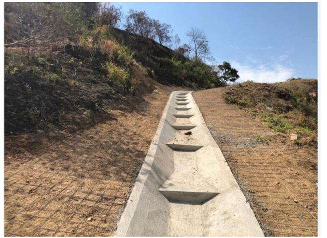
Figura 117 Drenagem Talude Km 15,7
