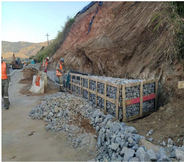
Figura 120 - Obra de recuperação do Talude Km 9+760
