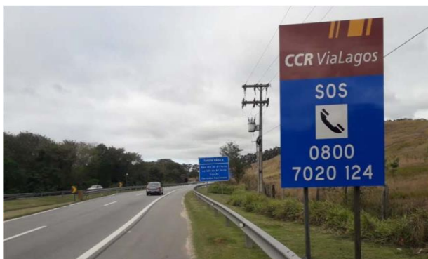
Figura 103 - Substituição de Placa - Km 21+500 Norte
