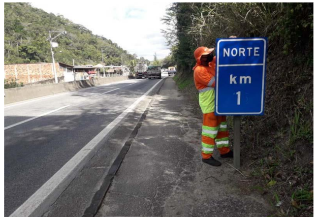
Figura 105 - Substituição de Placa - Km 1+000 Norte
