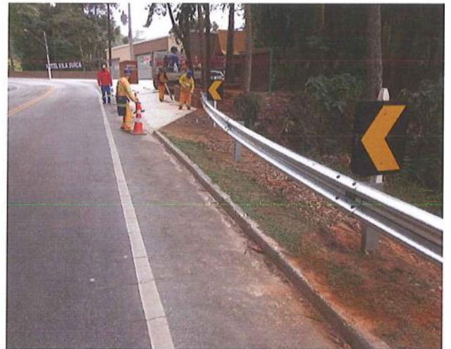
Figura 93 - Serviços de manutenção no acostamento da via.
