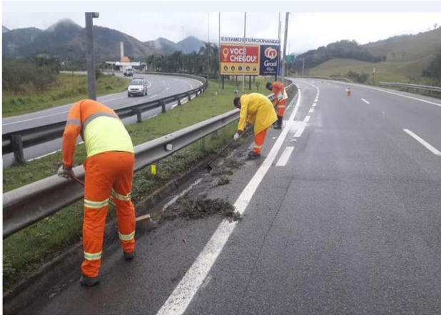
Figura 113 - Limpeza de sarjeta - Km 23+000 Sul
