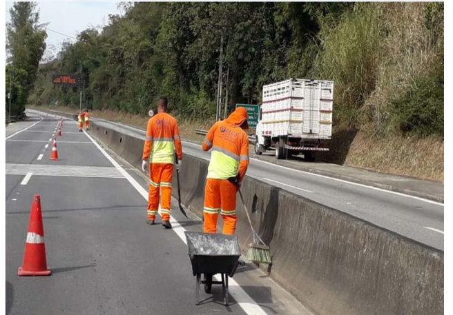
Figura 118 - Varrição da barreira divisória Km 4+500
