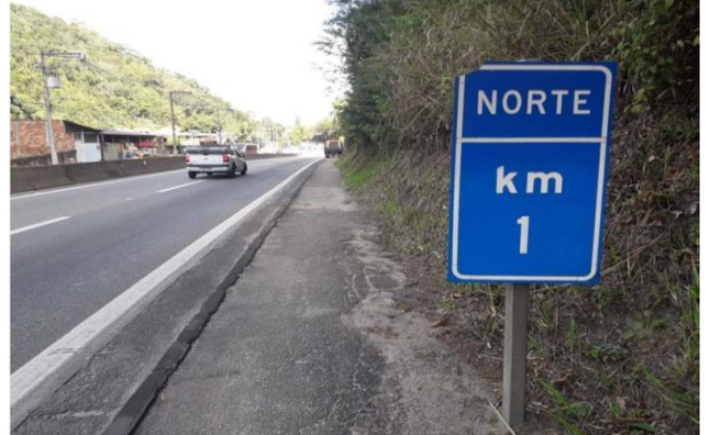
Figura 104 - Substituição de Placa - Km 1+000 Norte
