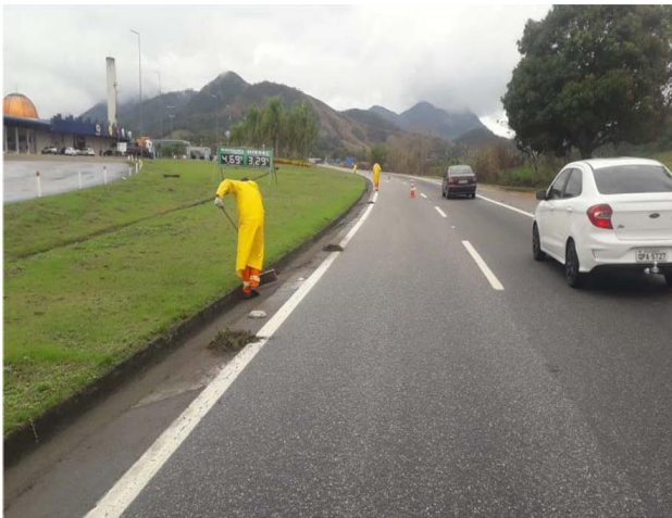
Figura 114 - Limpeza de sarjeta - Km 23+000 Sul
