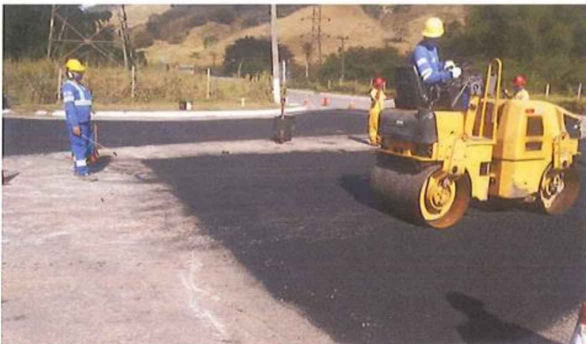
Figura 97 - Obra de manutenção da pista de rolamento da RJ 116
