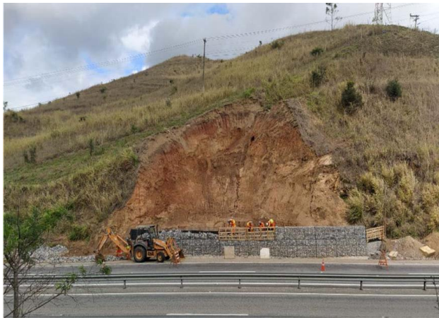
Figura 121 - Obra de recuperação do Talude Km 9+760
