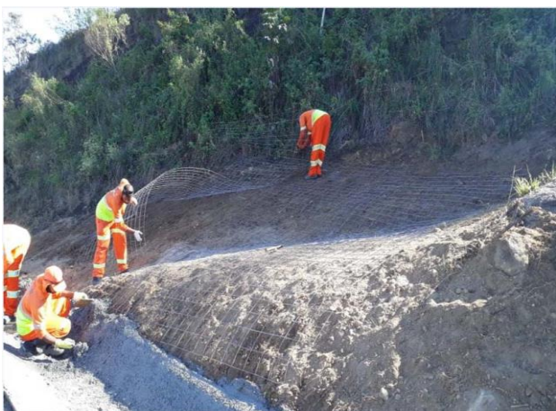
Figura 115 - Drenagem Talude Km 15,7
