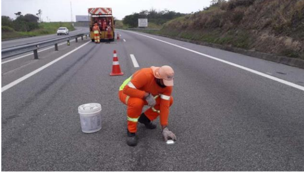
Figura 107 - Implantação de Tachas - Km 43+000 Norte
