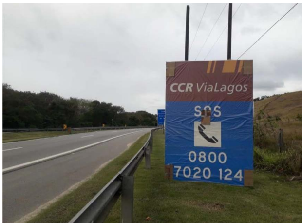
Figura 102 - Substituição de Placa - Km 21+500 Norte
