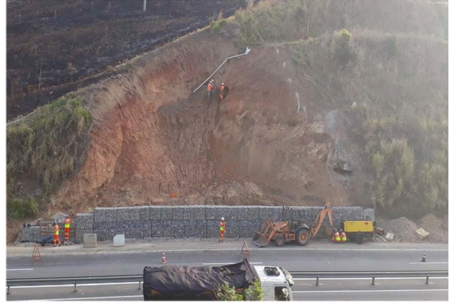
Figura 122 - Obra de recuperação do Talude Km 9+760
